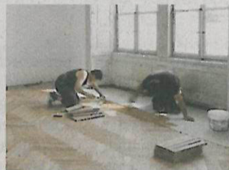
Profis beim Verlegen des Parkettbodens.
